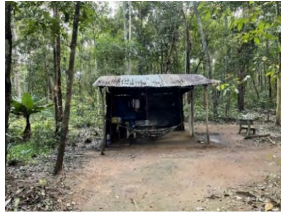
Hình 3.33. Lán tạm thời bảo vệ rừng tại BQL RĐĐ Đắk Uy
